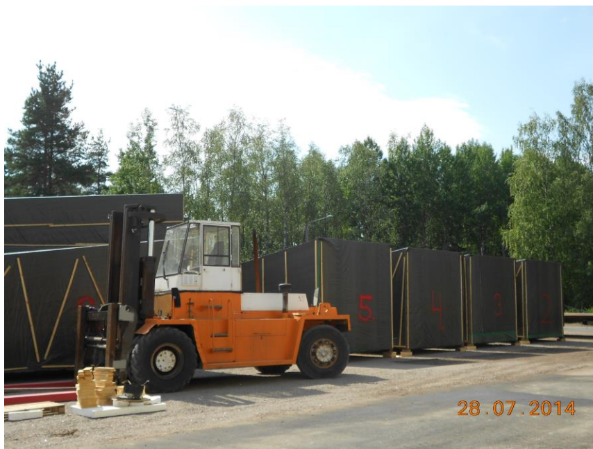
Kuva 7: Pakatut tilaelementit ennen työmaalle lähtöä
