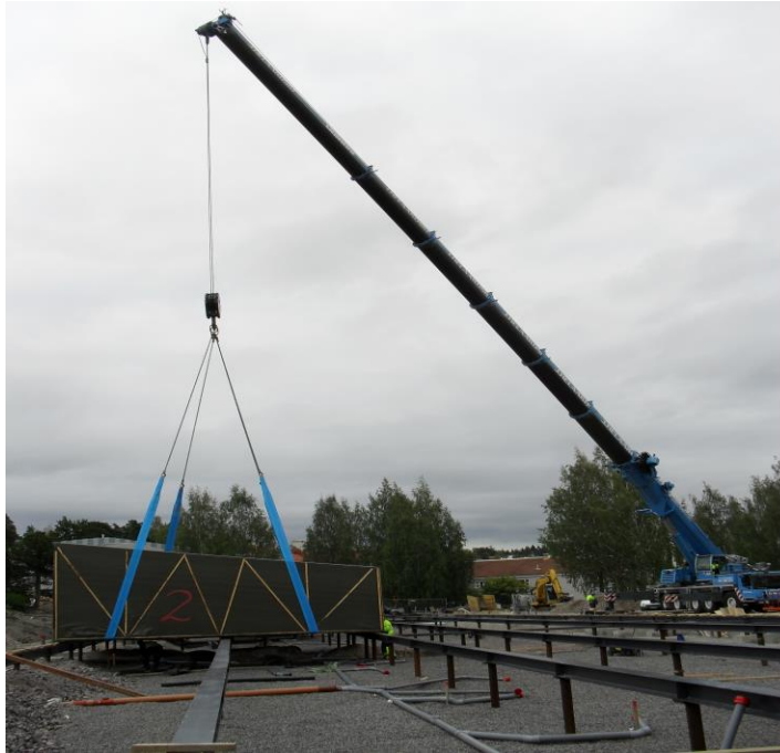
Kuva 11: Tilaelementin asennus perustusten päälle
